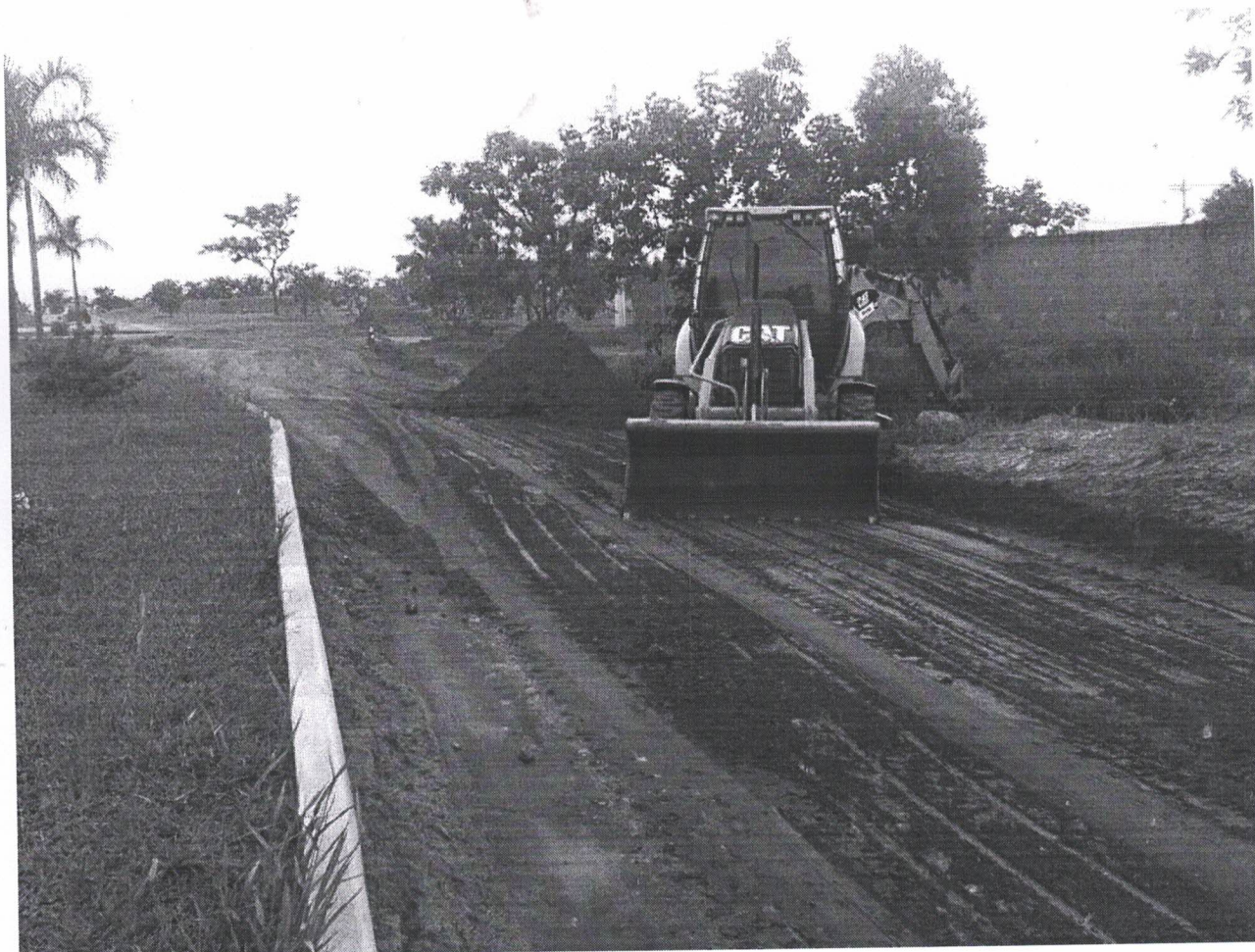
Manutenção de vias danificadas pelas chuvas, em 11/03/2020
