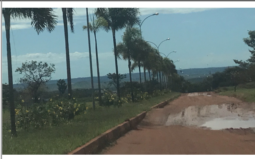
Foto 2. Lombada e canteiro central com cobertura vegetal em via de acesso não pavimentada.
