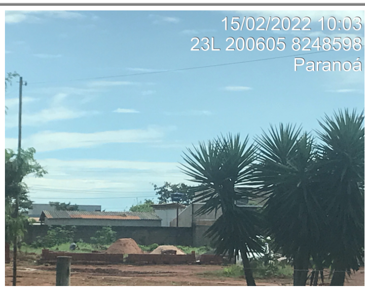
Foto 4. Material de construção para edificação de obra.
