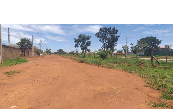
Foto 7. Processo erosivo mais acentuado observado em via de acesso não pavimentada. Ao fundo, área proposta do bota-fora sendo utilizada para depósito de resíduos da construção civil.
