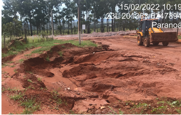
Foto 7. Processo erosivo mais acentuado observado em via de acesso não pavimentada. Ao fundo, área proposta do bota-fora sendo utilizada para depósito de resíduos da construção civil.
