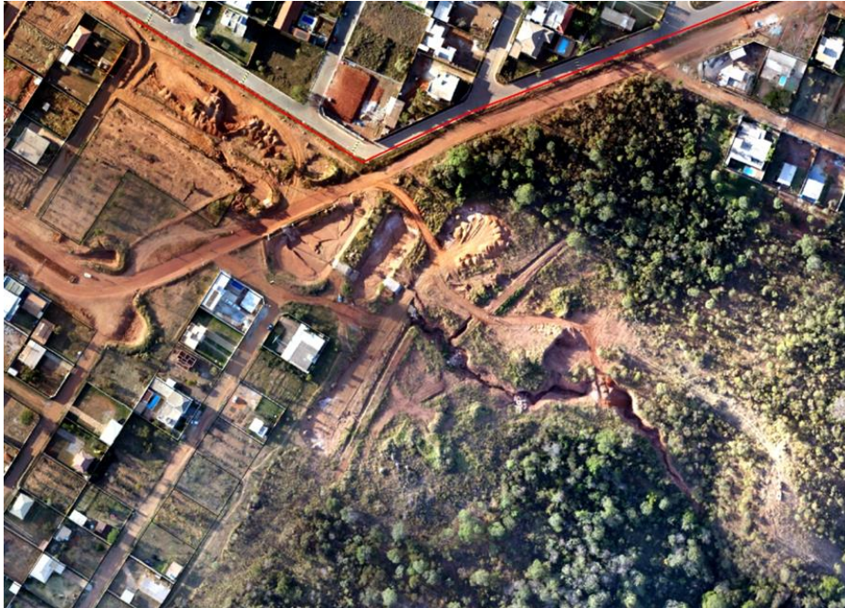
Figura 8 – Processo erosivo antes da implantação da bacia e canal.
