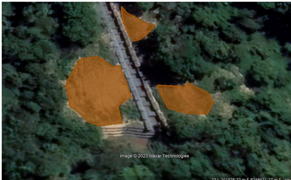
Figura 7 – Trechos que ainda não foram revegetados, considerando a movimentação de máquinas na faixa de serviço da obra – Imagem 03.
