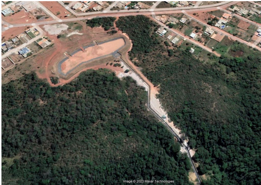
Figura 9 – Pós obra – estabilização do processo erosivo
