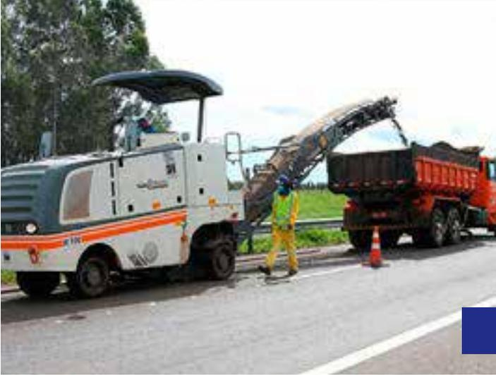
FRESADORA DE ASFALTO
